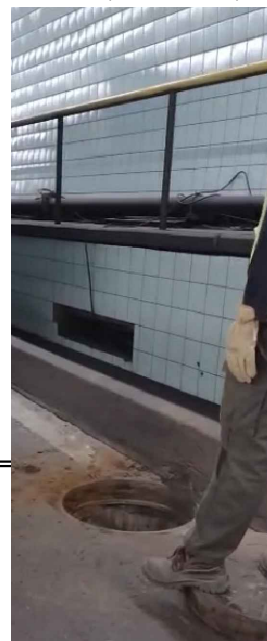
BOCA ACCESO EN CALZADA Ø60cm (DESTAPADA)
